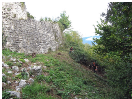
Débroussaillage sous le rempart
