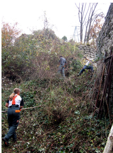
Débroussaillage sous la tour ronde
